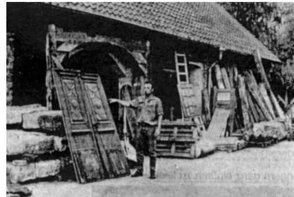
Lemgo-Entrup. Der 30jährige Martin Blöcher (Bild) gründete Im März 1988 seinen Fachbetrieb, der sich mit Baustoff-Recycling befaßt. Das Lager an historischen Baumaterialien hat bereits einen stattlichen Umfang angenommen.
