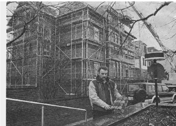
Martin Blöcher mit einem Verbund von Formziegeln vor dem Haus Treppenstraße 15, dessen Außenfassade – darunter ein weiteres Ziegelmauerwerk – in den nächsten Tagen Stein für Stein abgetragen wird. Foto: Arl
